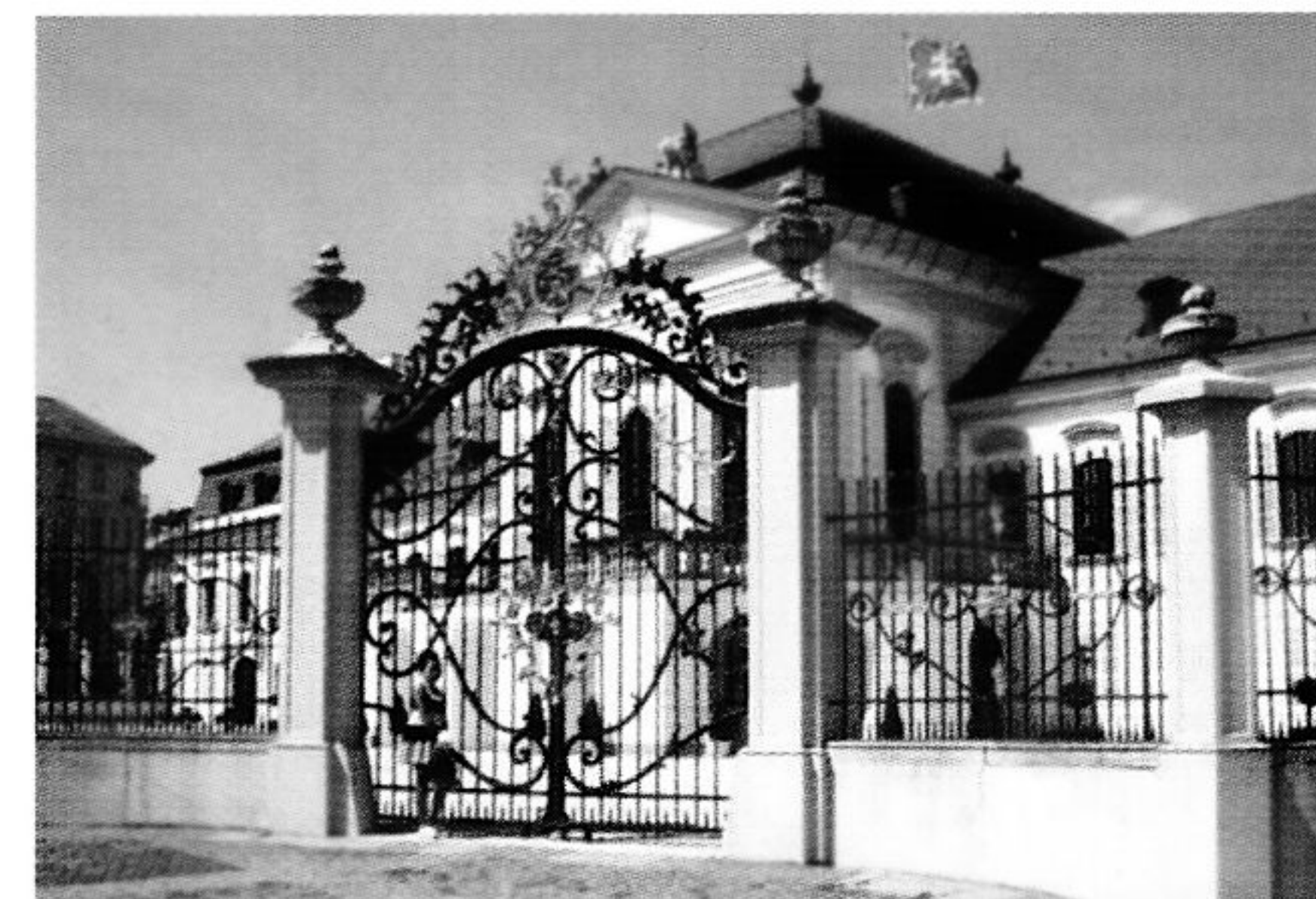
Obnova a rekonštrukcia Grassalkovichovho paláca, Bratislava, 1979
